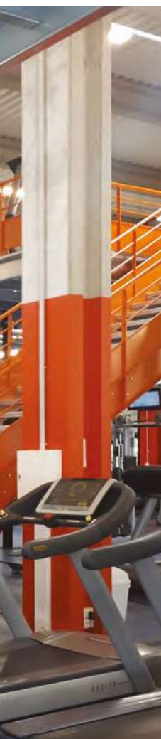
Escalier pour plateforme, avec première contremarche pleine et colorée. Inclinaison et largeur de marche confortables et conformes (DDI Rayonnage)
