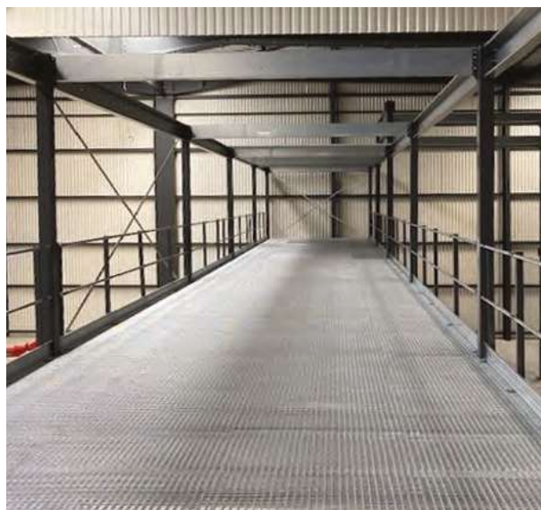
Passerelle avec plancher dallé de caillebotis, particulièrement recommandé pour les bâtiments équipés de systèmes de détection d'incendies et de sprinklage (GBG Concept)
