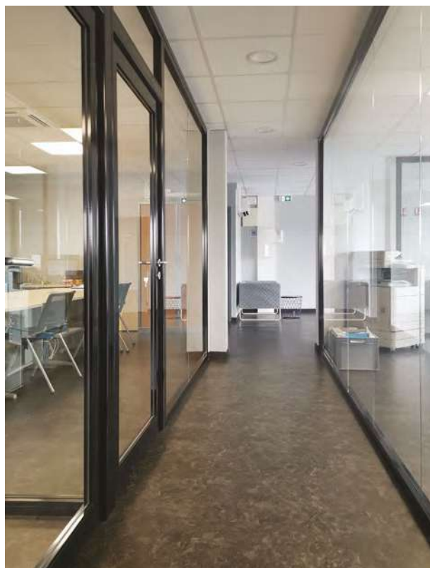
Création d'espaces bureaux avec des cloisons vitrées hauteur plafond (Araydis et GBG)
